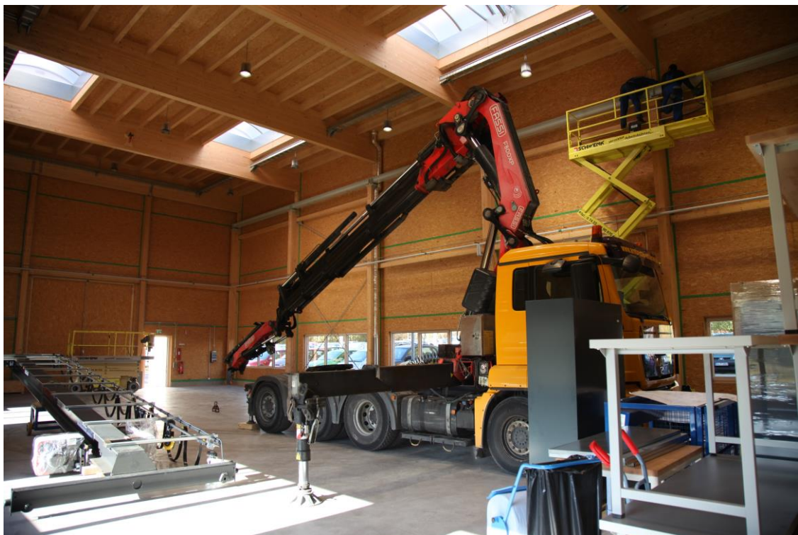
Abb. 6: Kraninstallation im Technikum, Herbst 2016
