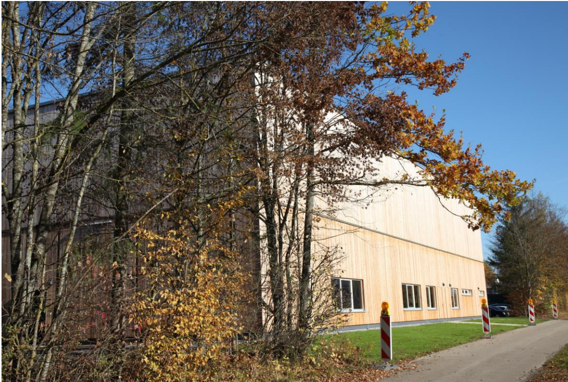
Abb. 5: Außenansicht des neuen Technikums der HFR, Inbetriebnahme 2016
